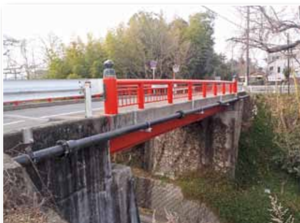
橋梁長寿命化 (松尾橋)
